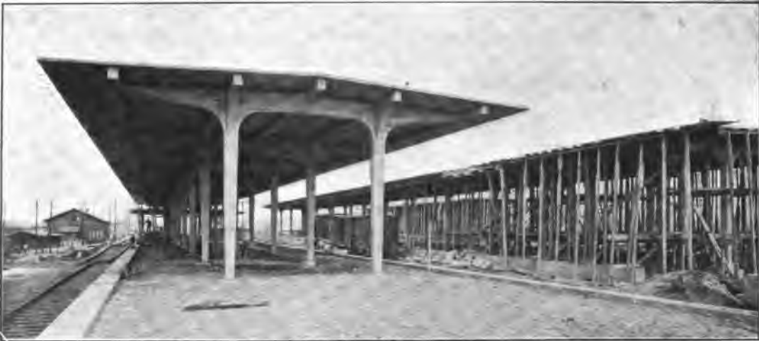
Abb. 96. Zweistielige Bahnsteighalle in Langendreer.
